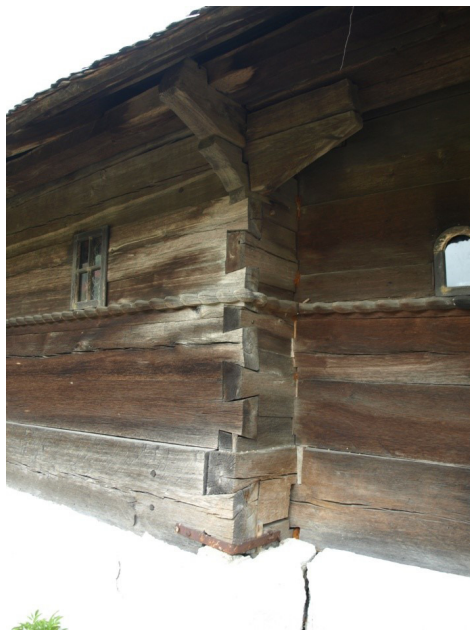
Foto 3: Sistemul de legare coadă de rândunică
